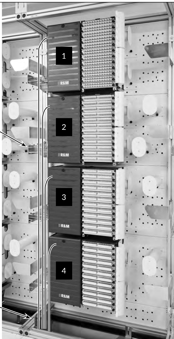
F7 Schutzschlauch nummerieren Number protective tube Numéroter la gaine de protection
